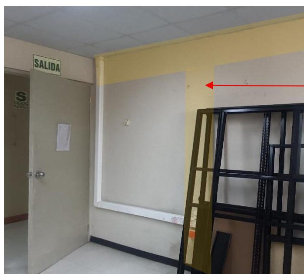
Recorte de muro para generar columna de drywall.
